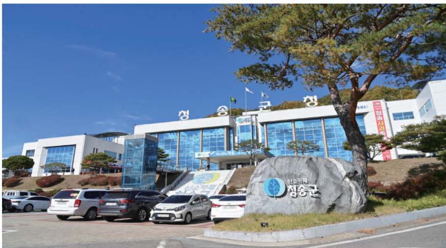
산림청 임업경영체 등록사무소(054-850-4116~7)로 문의하여 임업경영체 변경등록을 신청해야 읍·면 사무소를 재차 방문하는 번거로움을 없앨 수 있다. 임업직불금 신청기간이 마감되면 자격요건 검증을 통해 5월에 지급대상자를 확정 후 소득검증과 의무준수사항 이행점검을 9월까지 진행하고, 그 결
