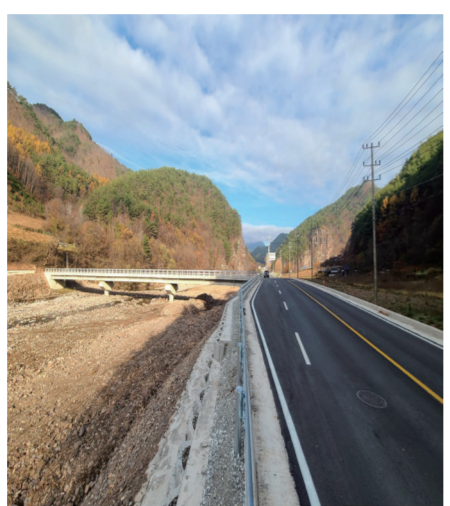
▲음지교 교량 설치
