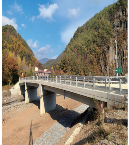
▲오리고 교량 설치
