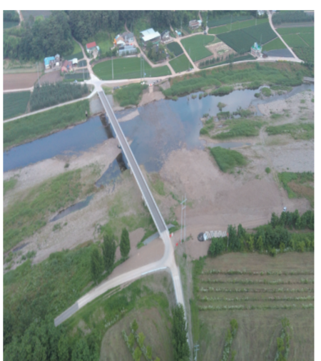
▲지평지구 감천교 교량 설치
