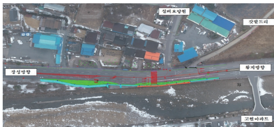
9월까지 좌회전 전용 1개 차로를 신설할 계획이며, 이번 공사를 통해 △좌회전 전용 차로 신설 △신호등 설치 및 이설 △신주·가로수 이설 등을 시행한다.
